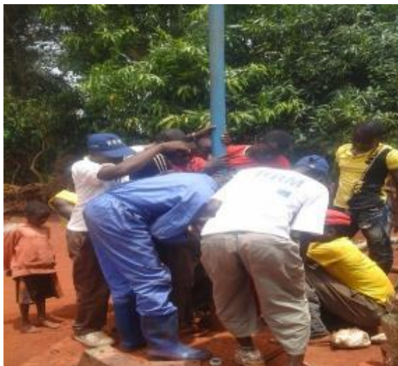
Travaux de réparation de la pompe de Dembia
