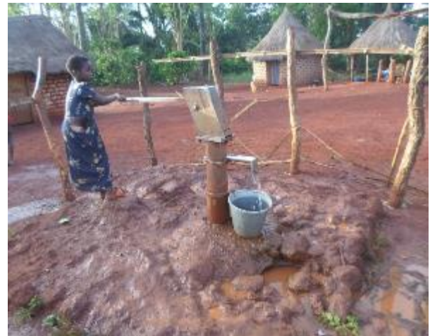
Pompe réparée en attente de la réhabilitation de la margelle
