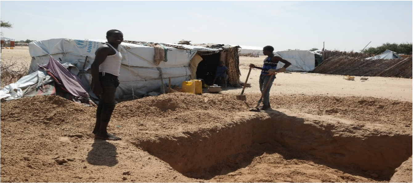
Implantation de latrines familiales au Camp Sayam Forage – Appui à 150 ménages en situation d’handicap physique / Photo UNHCR – Ibrahim Abdou/Relations Extérieures
