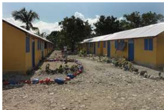
Un village transitoire construit à Léogane. Crédit Photo: MINUSTAH.
