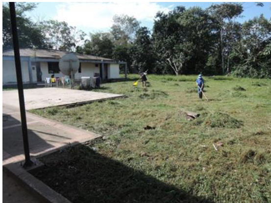
Credito: Nicolás Mayr. OCHA Limpieza de las zonas verdes y pintura en la fachada del centro de salud.
